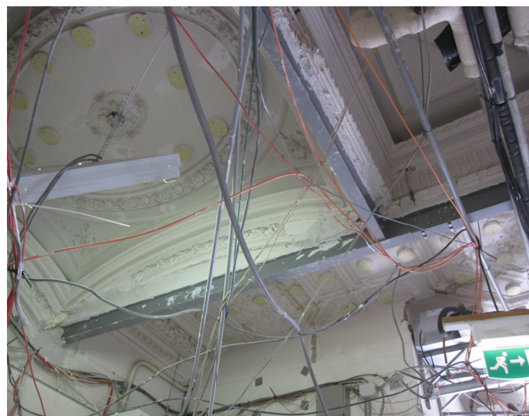
DÉTAIL DU PRINCIPE DE RENFORCEMENT DES PLAFONDS DU 5 e ÉTAGE
