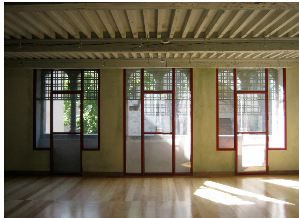
Vues intérieures de la Maison des Chanonges restaurées et aménagées : plafond dont la sous-face comporte des décors restaurés a été consolidé par une dalle en bois, le sol en carreaux de terre cuite rappelle l'ancien compartimentage du volume, le traitement résolument contemporain de certains détails est combiné à la restauration stricto sensu des vestiges hérités.
