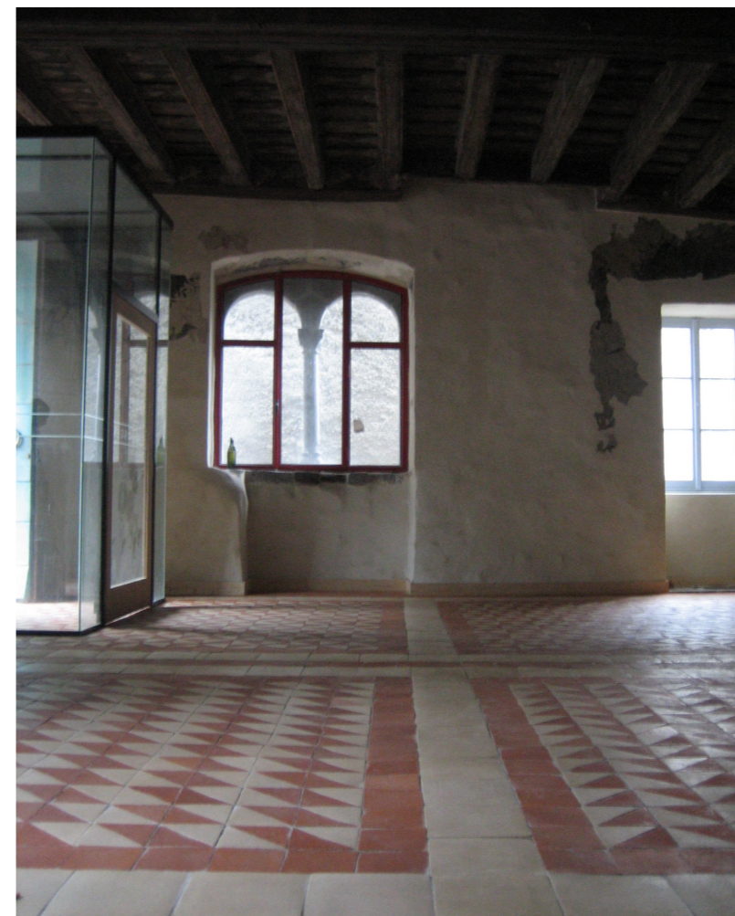
Vues intérieures de la Maison des Chanonges restaurées et aménagées : plafond dont la sous-face comporte des décors restaurés a été consolidé par une dalle en bois, le sol en carreaux de terre cuite rappelle l'ancien compartimentage du volume, le traitement résolument contemporain de certains détails est combiné à la restauration stricto sensu des vestiges hérités.
