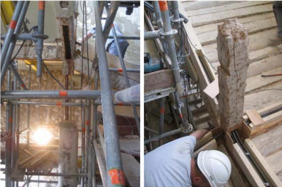
chantier : suppression de poteau béton et renforcement de limon
